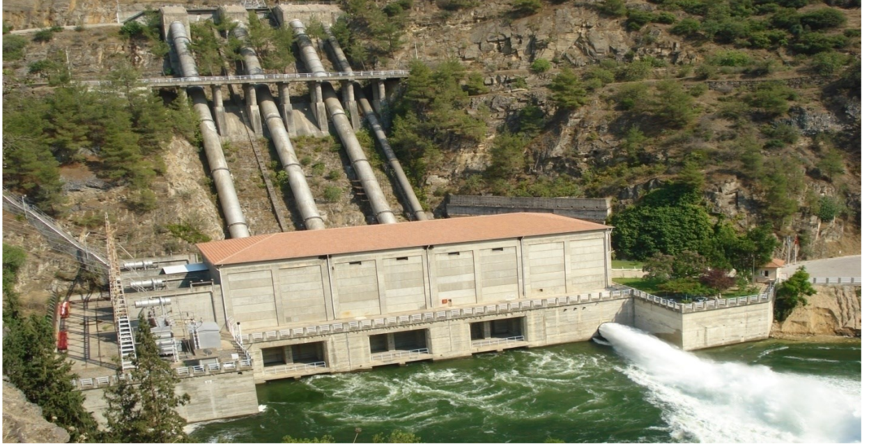
Şekil 3. Hidro elektrik santrali görünümü
